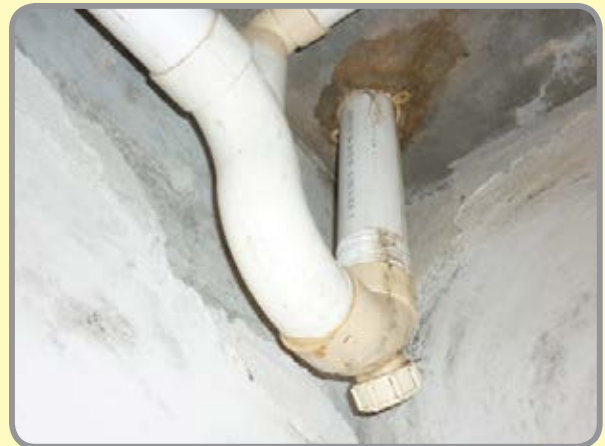
Gambar 2 – Untuk membuang serpihan yang terperangkap, penutup pelindung perlu dibuka. Bagi mengakses perangkap lantai jenis P ini pekerja perlu menggunakan tangga kerana lokasi yang agak tinggi.
