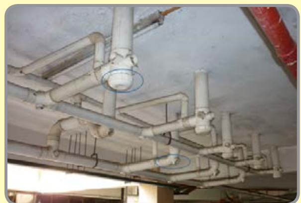
Gambar 3 - Untuk menghilangkan serpihan yang terperangkap di dalamnya, buka penutup dan peralatan yang bersesuaian mungkin diperlukan kerana penutup yang ketat. Selain itu, tangga juga diperlukan untuk mengakses Perangkap Lantai P Jenis Konvensional.
